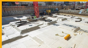
IMPERMEABILIZAÇÃO DE SUBSOLOS
